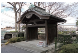
板橋宿貸座敷「新藤楼」の玄関
