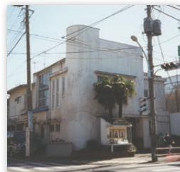
常盤台写真場 江戸東京たてもの園移築前写真
